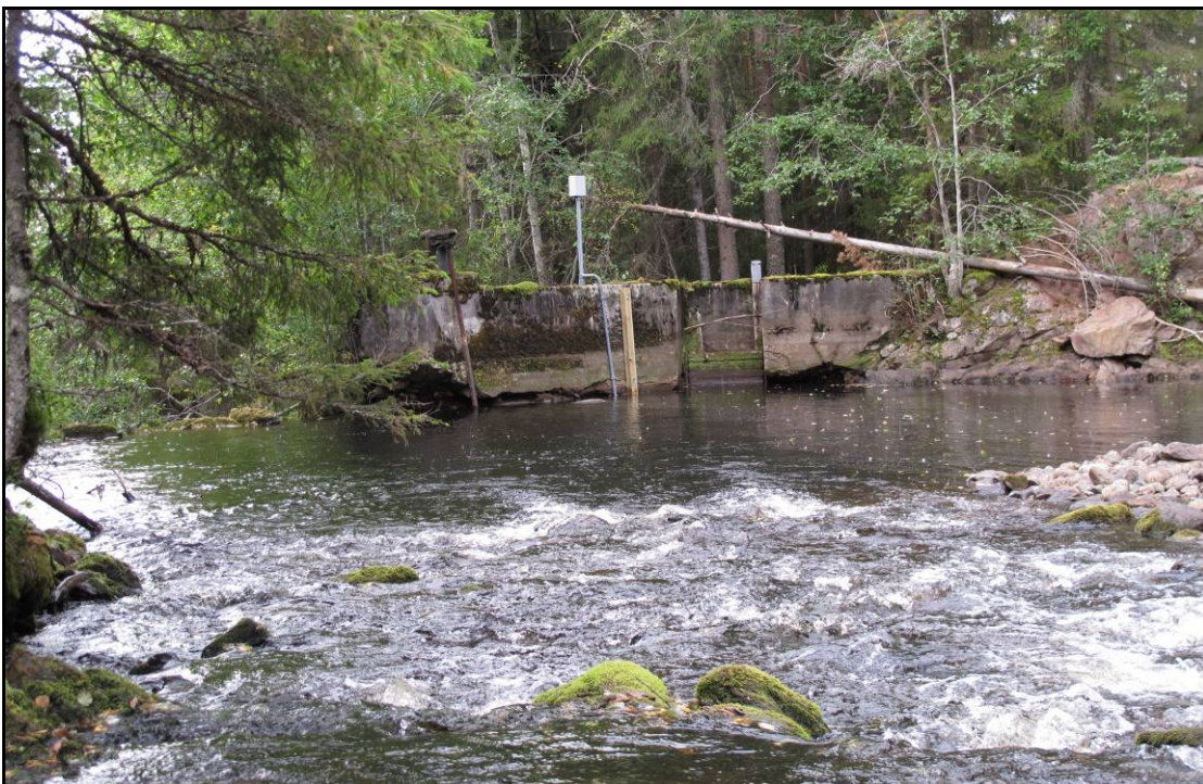
Figur 4.4. Fra området hvor kraftstasjonen i Deia er planlagt. Foto Ole K. Larsen
